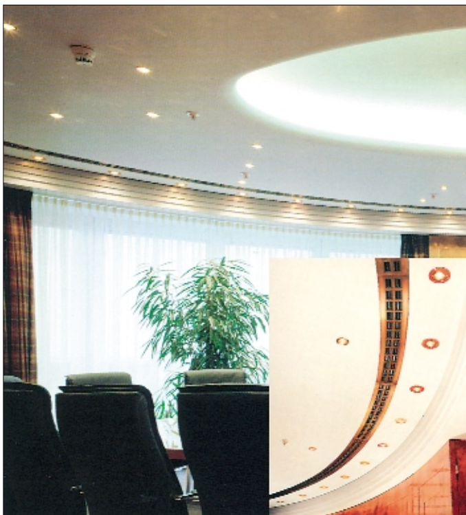
Rys. 4. LTG nawiewnik szczelinowy Coandatrol®, LDB 9
