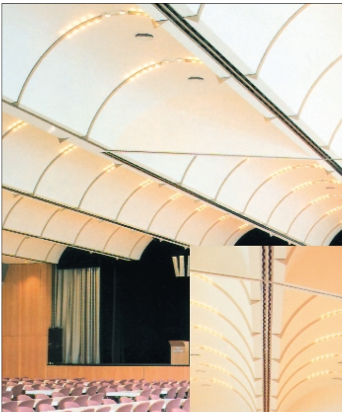
Rys. 3. LTG nawiewnik szczelinowy Coandatrol®, LDB
