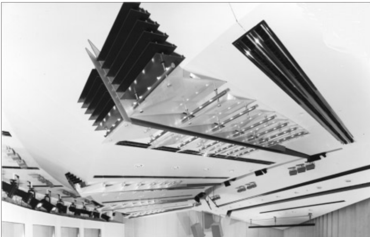
Przykład zastosowania nawiewnika szczelinowego typ LDB 50, Liederhalle, Stuttgart
