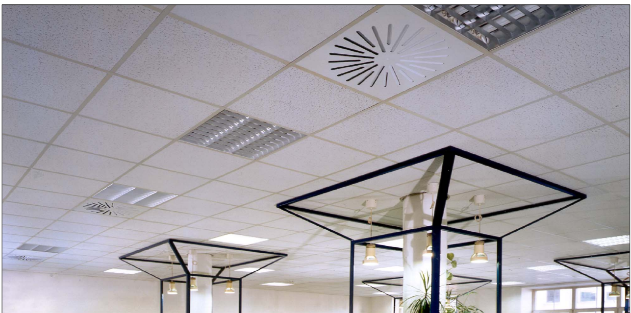
Einbaubeispiel Drall-Luftdurchlass Typ DLA 7
