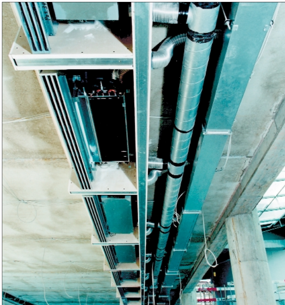
Rys. 3. System INDIVENT w fazie montażu
